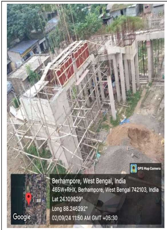
BEHARAMPORE STP SITE
